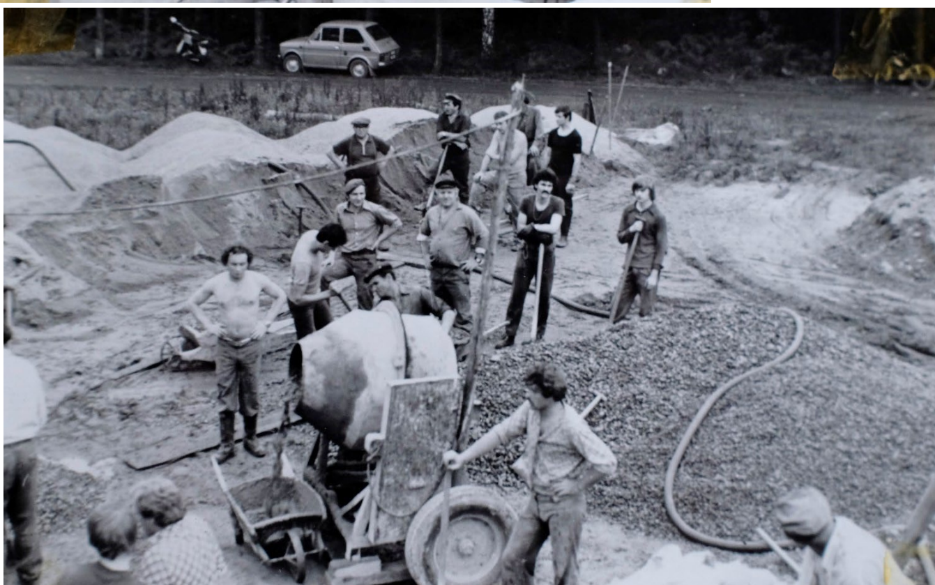
Betonowanie deki
