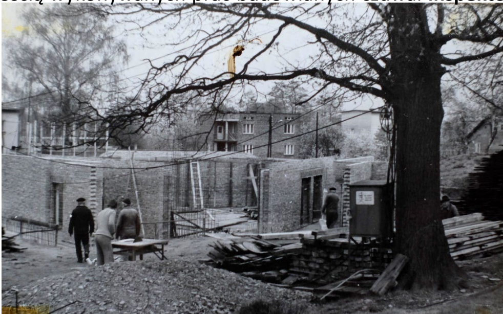
Przygotowania do kładzenia deki
