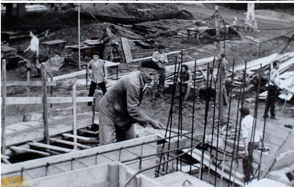
Betonowanie deki
