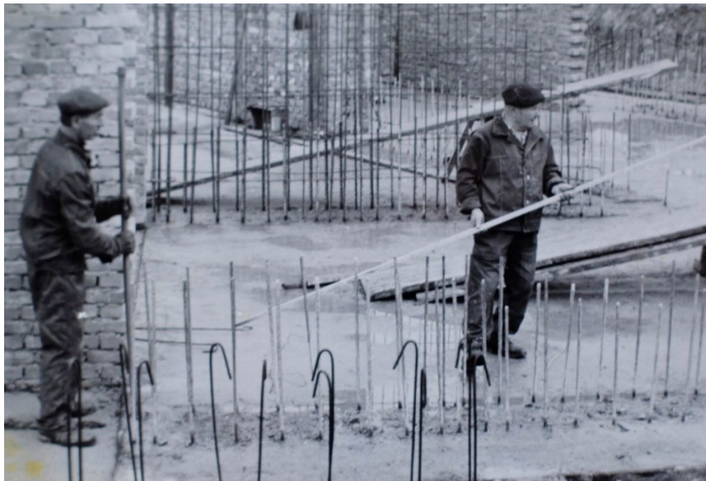
Zbrojenie i betonowanie p. Krawczyk i Handzlik
